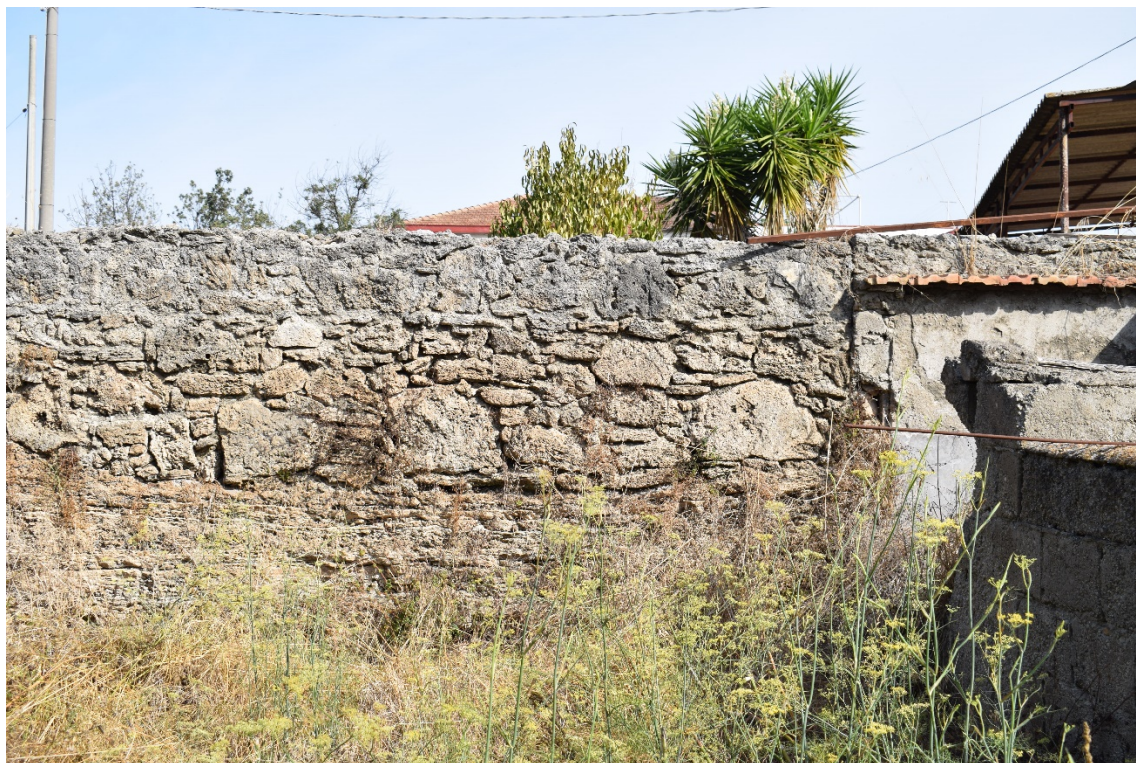
Foto 35 – U.R. 2 Particolare del banco di travertino affiorante e lavorato a forma di “L” e coperto da una struttura costituita da pietre di varia natura e di dimensioni decimetriche e centimetriche legate da cementina. Vista da S.
